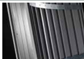
Detalhe das paredes do caixilho
